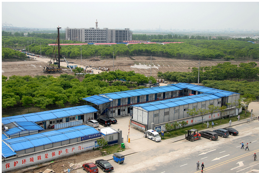
近处初期的临时办公房和食堂与远处即将竣工的新食堂和宿舍综合楼
